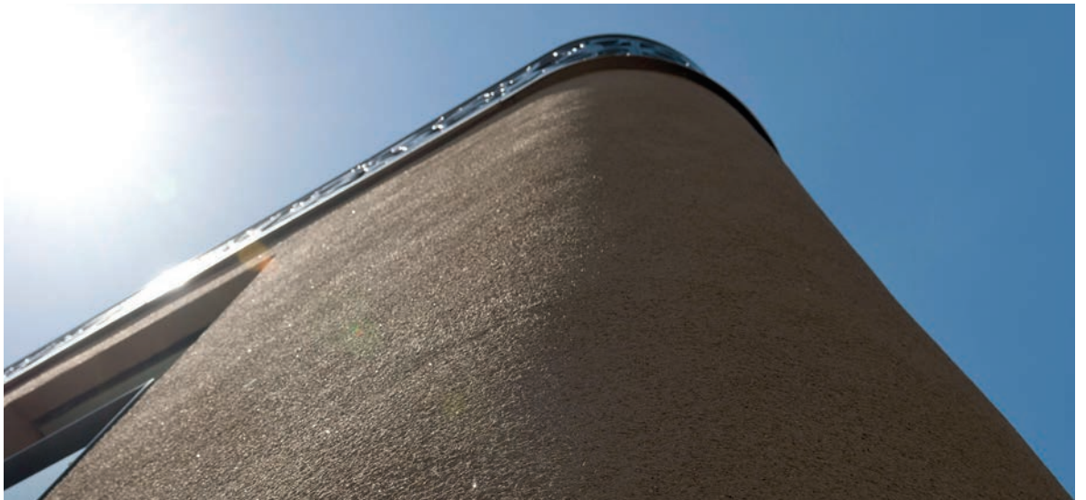
Mehrfamiliengebäude in Zürich Witikon, Objektgrösse 1348 m 2 . Systemaufbau: Dämmung mit Steinwolle, 240 mm, Grundbeschichtung Greutol Einbettmörtel light 425, Netzeinbettung Greutol Multiplanspachtel 407, Deckbeschichtung Greutol Kratzputz light 585.
